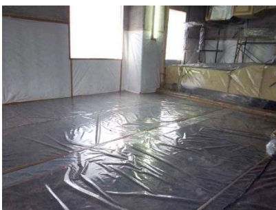
隔離用シートにて施工区画の隔離
