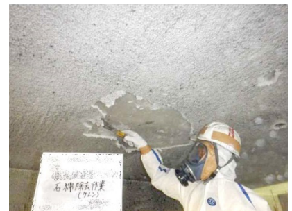
石綿含有吹付け材の除去
