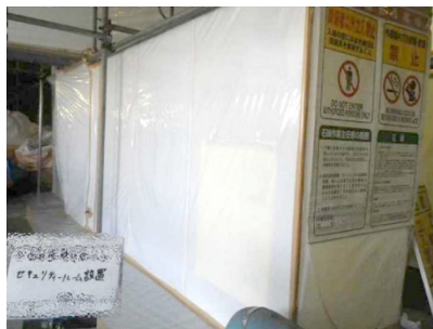
施工区画の隔離(セキュリティーム)
