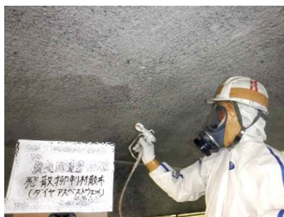
石綿含有吹付け材の湿潤化
